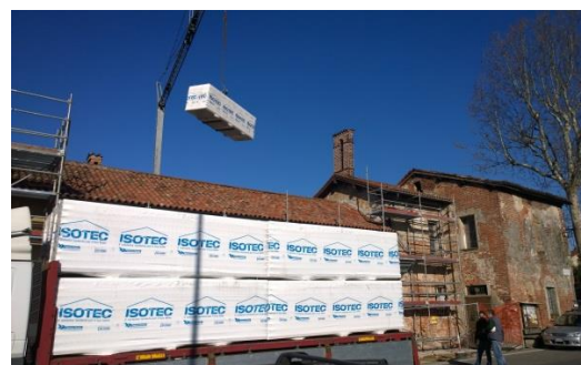
I lavori di restauro conservativo in corso a Cascina Linterno
