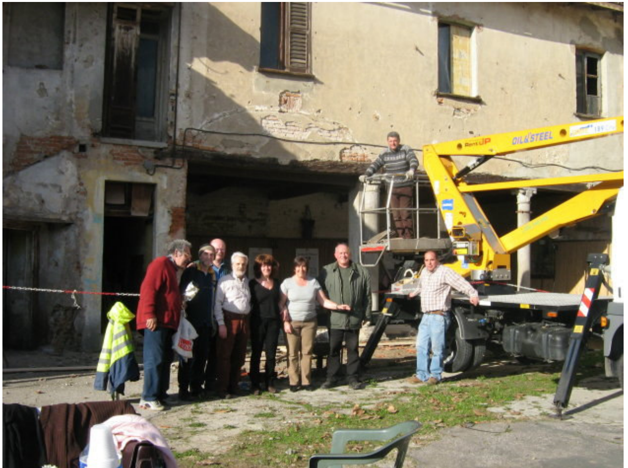
Conclusione dei lavori
